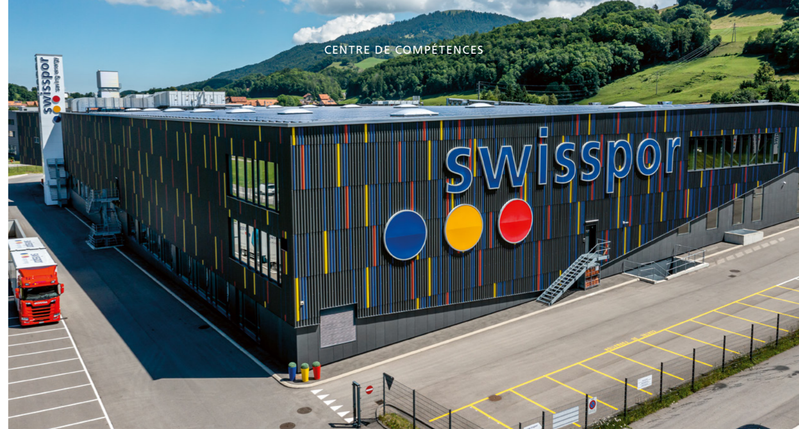
Centre de compétences (CDC) de swisspor Romandie SA à Châtel-St-Denis.
