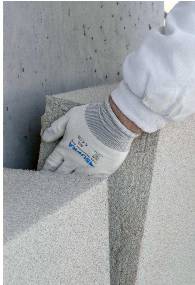
Application de l'isolation de façade avec swissporECORIT.
