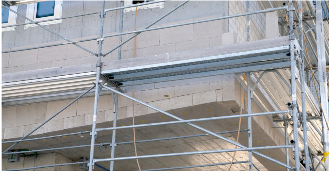
Transition entre la façade et la sous-face avec swissporECORIT.
